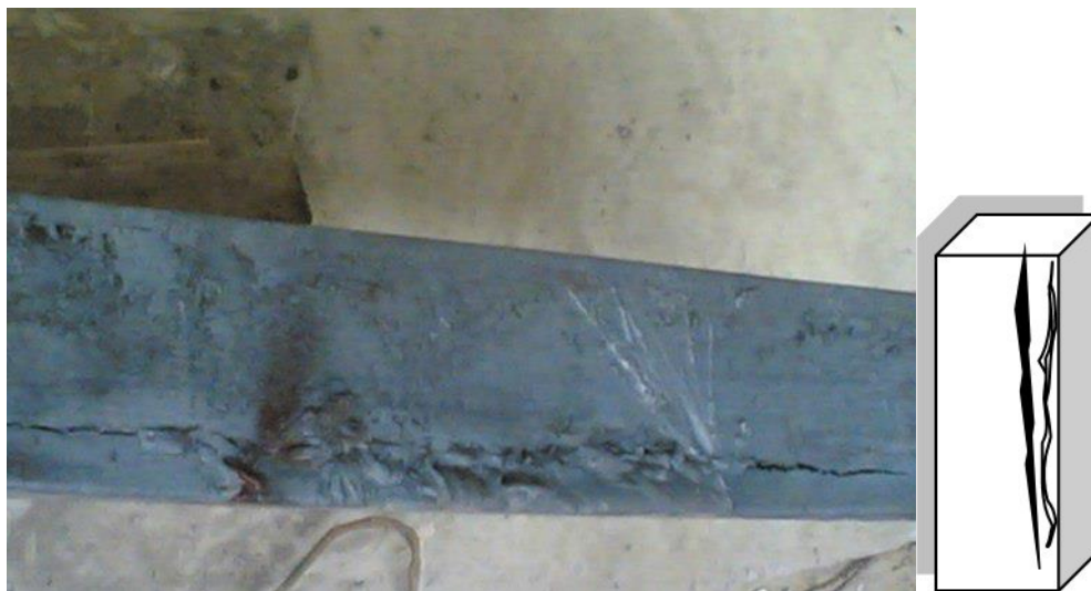
FACE CRACK (LENGHWISE)
