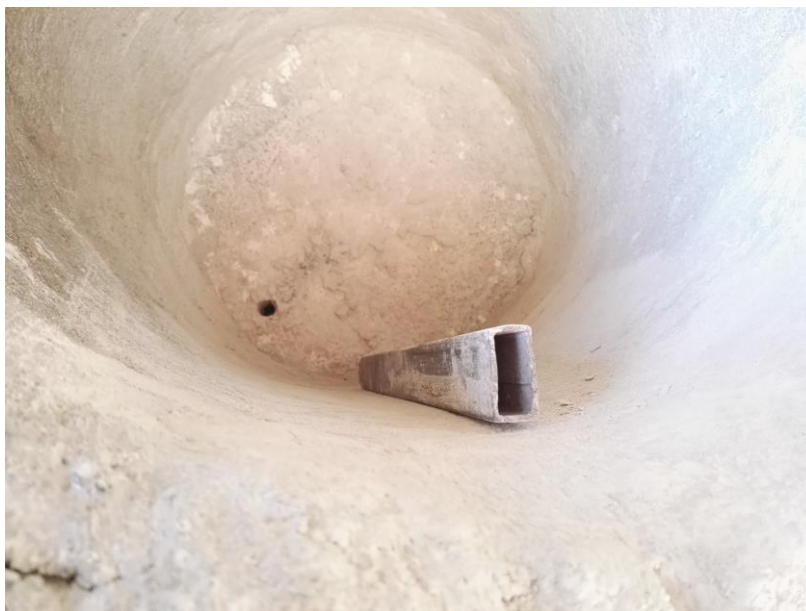
شکل ۱- تست تراز سطح کوره قبل از کوبیدن نسوز جدید
